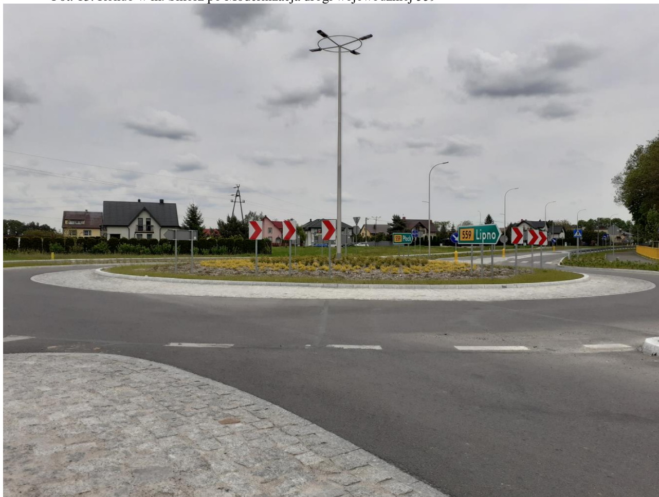
Fot. 13. Rondo w m. Sikórz po Modernizacja drogi wojewódzkiej 559
